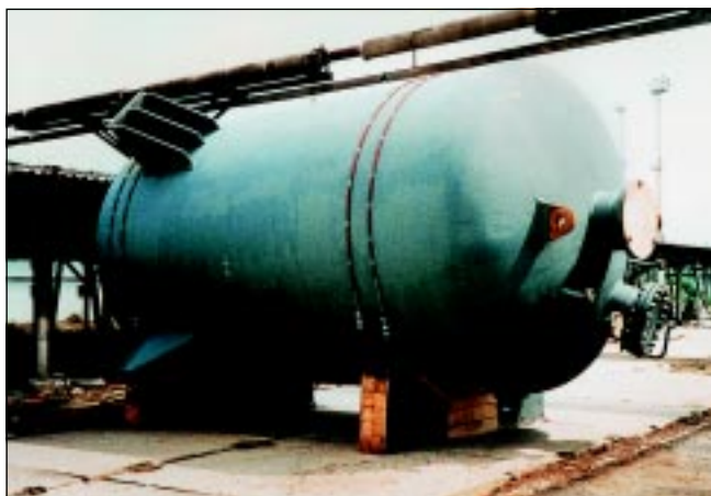
Vnútročné povrstvenie nádrže v chemickej továrni
