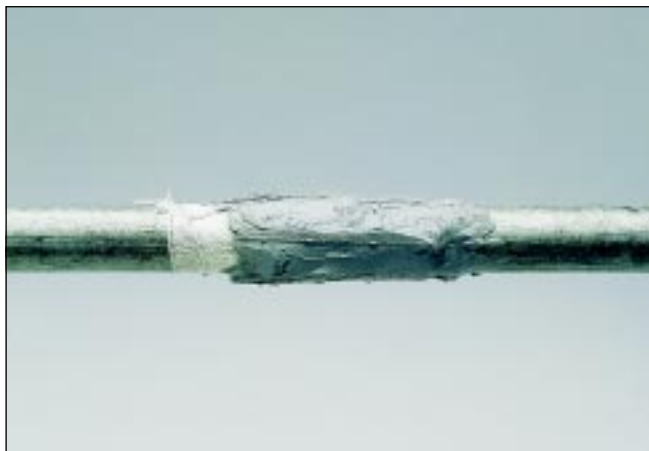
Núdzová oprava ocelevej trubky
