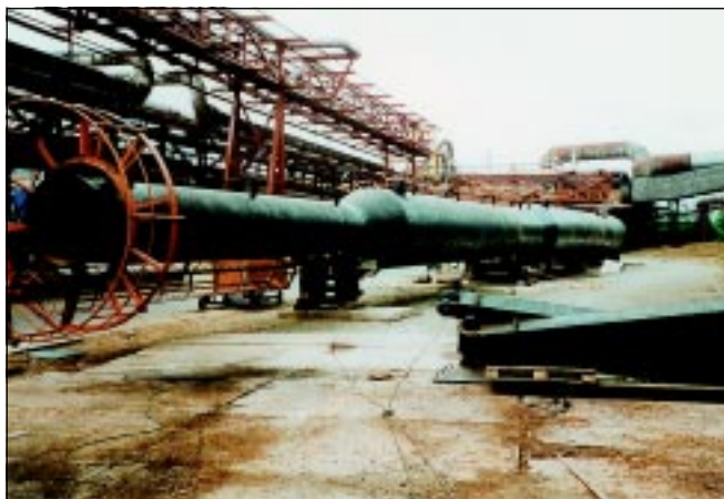
Ropná fľaľa v petrochemickej továrni.
